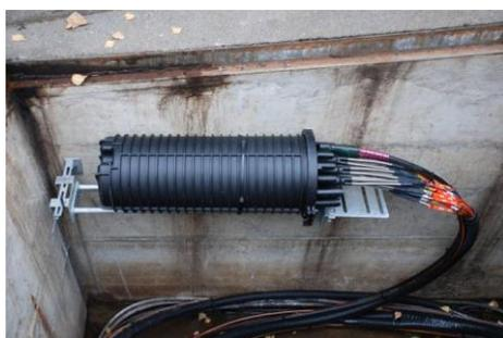
Abbildung 18: Verlegung Spleissmuffe
