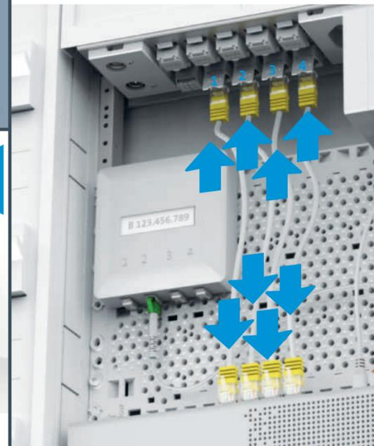
Les ports de l'armoire de distribution correspondent aux prises réseau dans vos pièces (numéro identique). Vous pouvez y connecter des appareils à Internet par câble.
